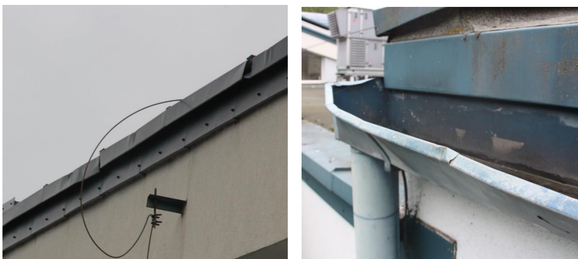
Uszkodzenia obróbek blacharskich i oryrynnowania
