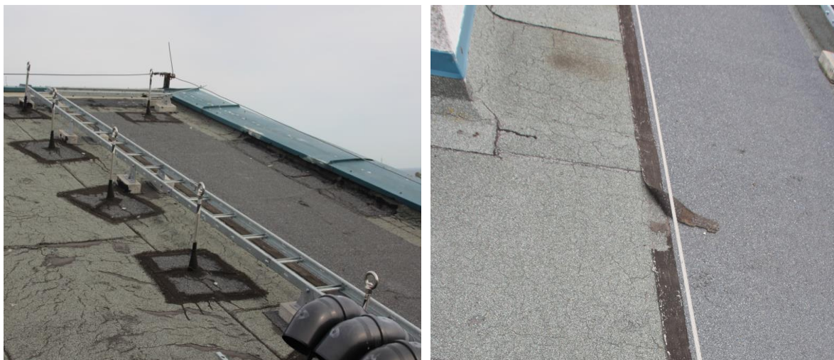
Uszkodzenia pokrycia połaci dachowej
