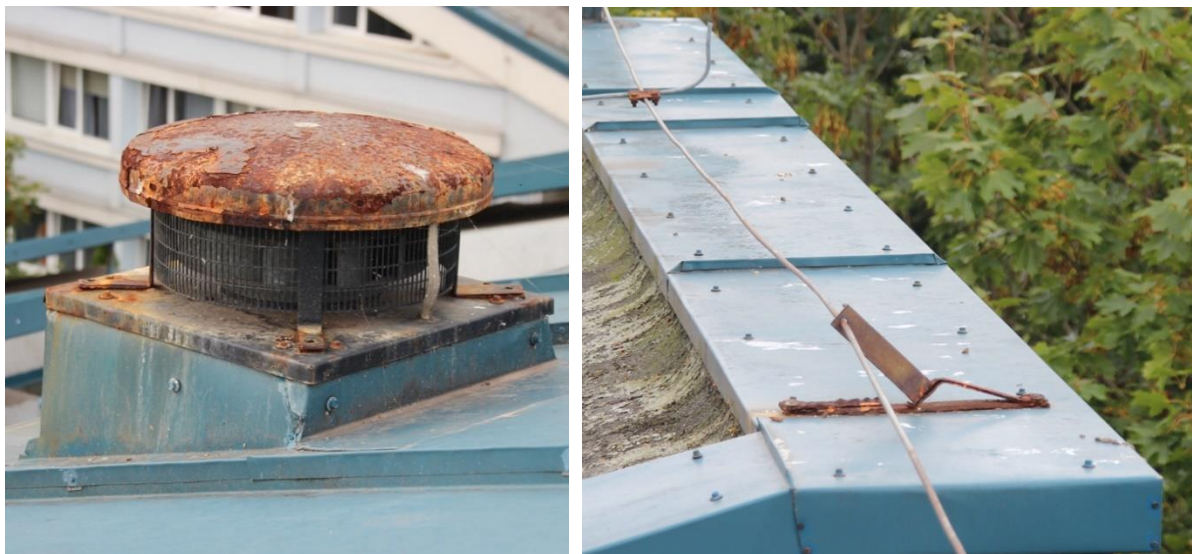
Ogniska korozji na elementach instalacji
